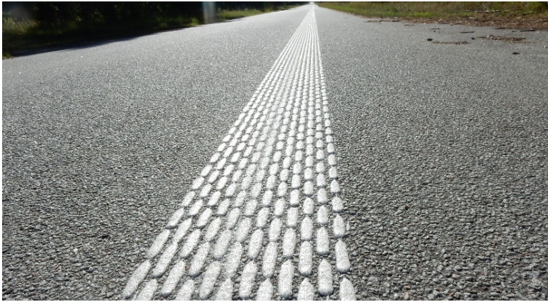
Figur 1. Udlagt vejstribe med LongDot. Foto Jesper Galsgaard.
